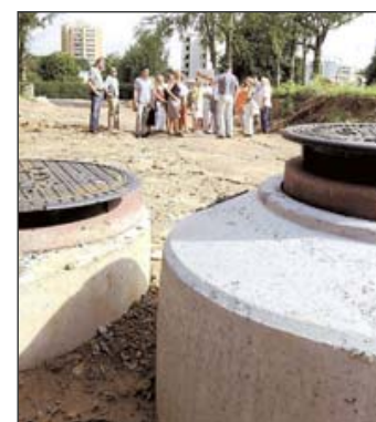
Im Werden: Noch ragen die Schachtdeckel hoch über die künftige Straße hinaus.
